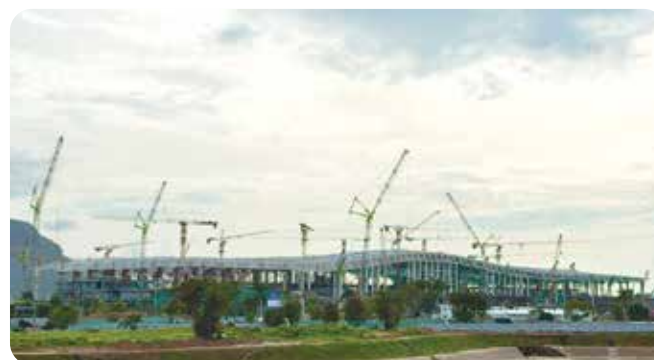
Toàn cảnh đại công trường Nhà ga T2
