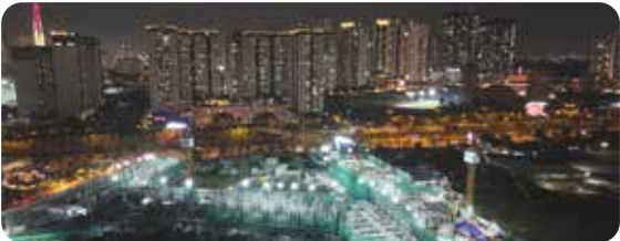
Đại công trường Eaton Park thi công liên tục ngày đêm kiểm soát chất lượng chuẩn GQUAS
