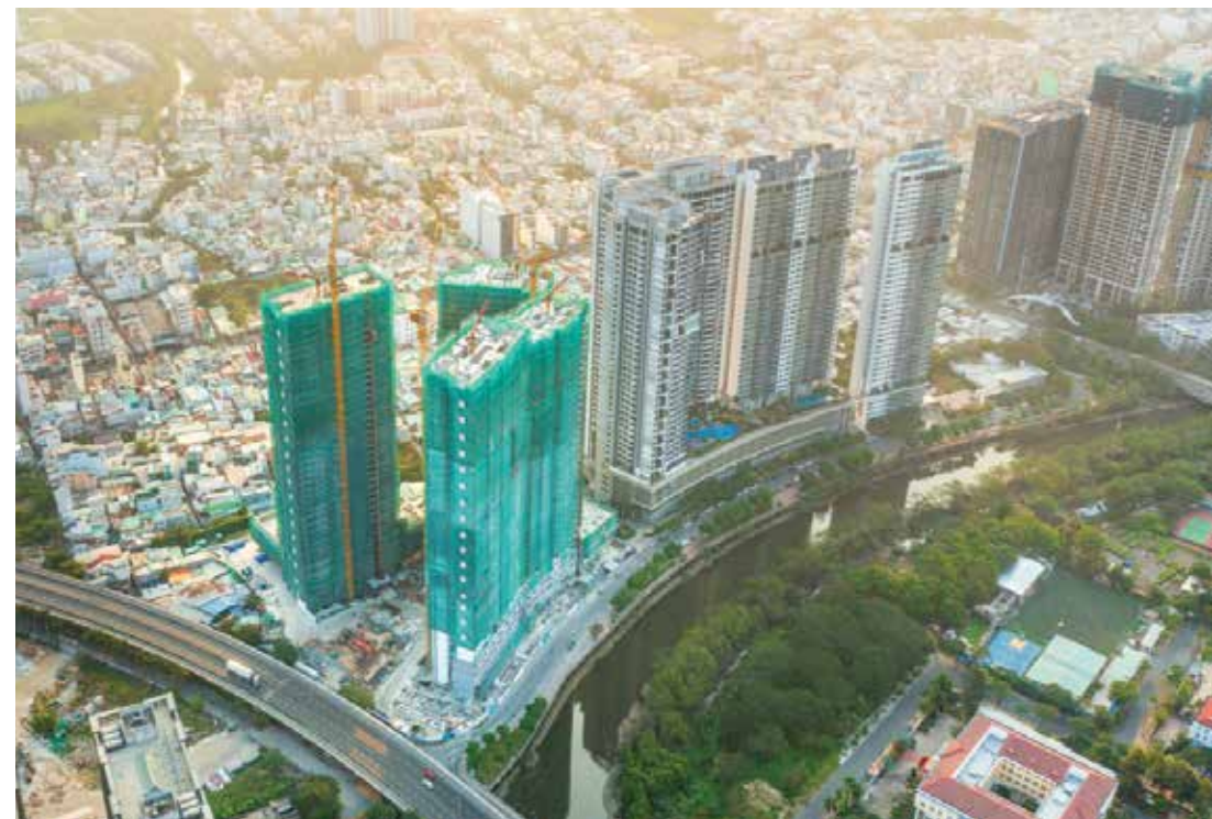
Dự án The Infiniti (Riviera Point - Giai đoạn 1C) TP.HCM - công trình cao tầng đầu tiên tại Việt Nam ứng dụng công nghệ bê tông khoáng hóa CO 2 , góp phần giảm phát thải carbon trong quá trình xây dựng.
