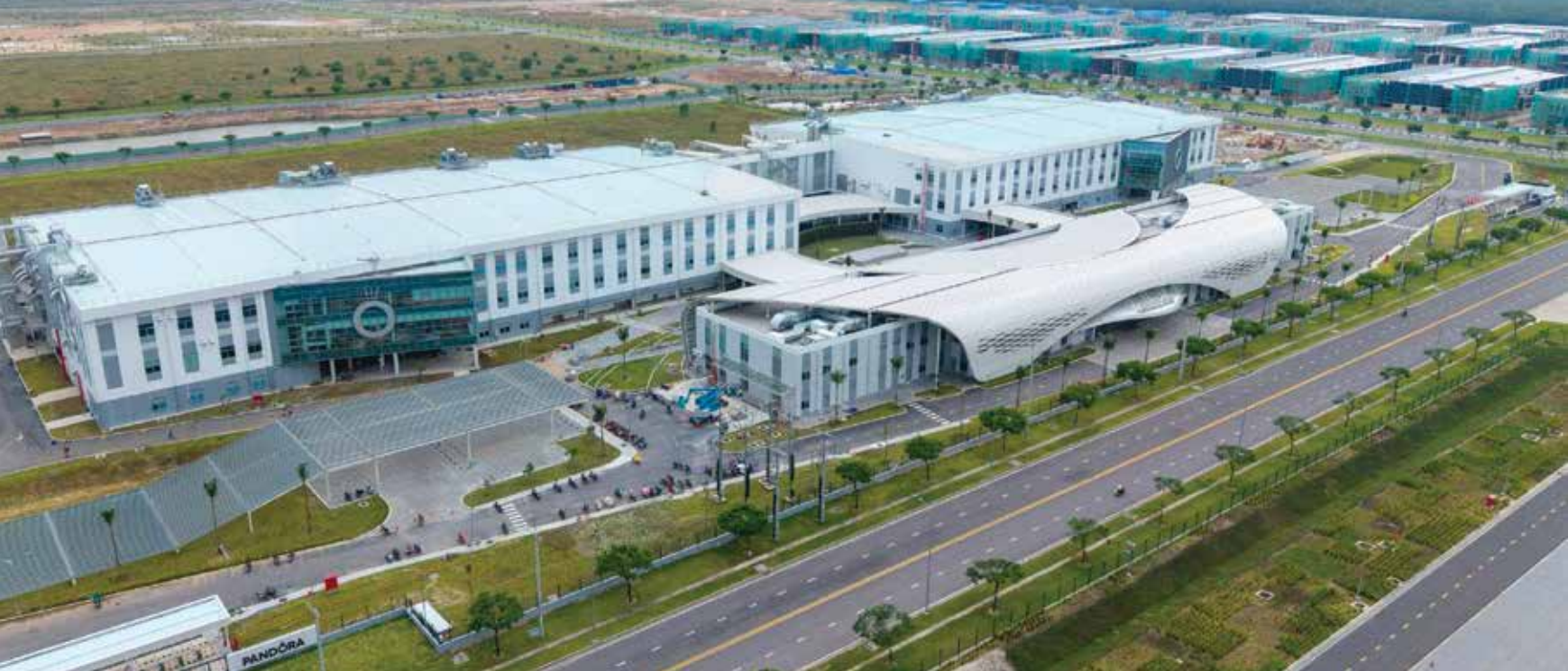
Tại dự án Nhà máy Pandora Production Việt Nam (TP.HCM), Coteccons chú trọng lựa chọn vật liệu cao cấp, máy móc nhập khẩu hiện đại và các nhà thầu phụ uy tín nhằm đảm bảo độ bền, tính ổn định cho các hạng mục quan trọng.
