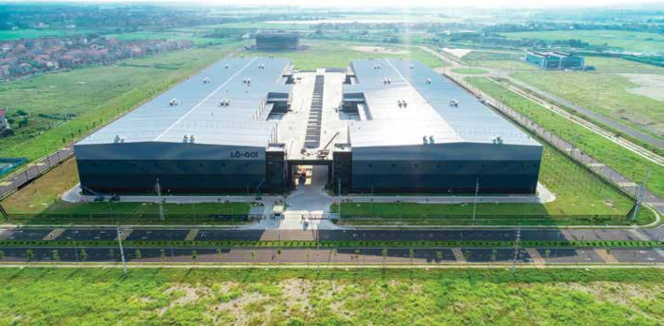
Tại KCN Yên Phong II-A (Bắc Ninh), Coteccons cùng Tập đoàn LÔ-GOI đã kiến tạo Tổ hợp Công nghiệp & Logistics 2 tầng hoàn toàn mới tại miền Bắc, xây dựng theo tiêu chuẩn xanh LEED Gold, tiên phong đón đầu xu hướng logistics hiện đại, tự động hóa và bền vững.
