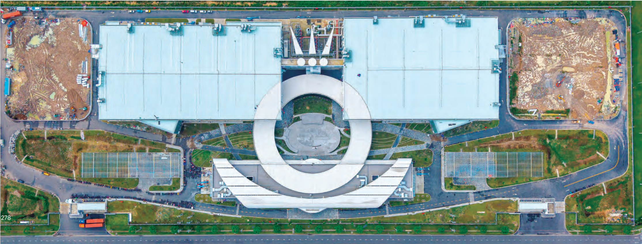
Coteccons bàn giao nhà máy chế tác trang sức Pandora đầu tiên tại Việt Nam sau 15 tháng thi công, đáp ứng các tiêu chuẩn cao nhất về an toàn, chất lượng và phát triển bền vững.
