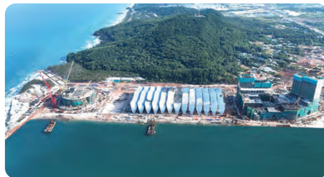
Toàn cảnh đại công trường ven biển Phú Quốc thi công đồng loạt 3 phân khu S2, S3 và tháp S4
