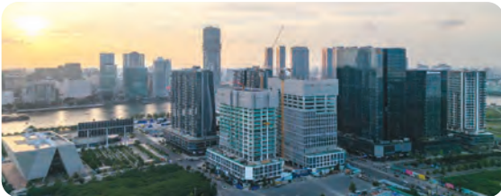
Thực tế thi công tòa tháp OpusK vươn cao trong cụm đô thị The Metropole Thủ Thiêm bên sông Sài Gòn
