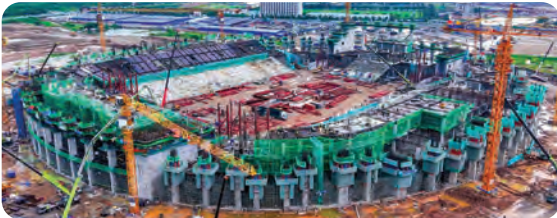
Công trường thi công thần tốc 270 ngày lắp đặt 84 cột biên và kết cấu 9 tầng khán đài chuẩn FIFA
