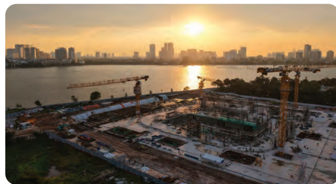
Toàn cảnh công trường thi công kết cấu hồ nhạc và móng phức tạp dưới hoàng hôn Hồ Tây
