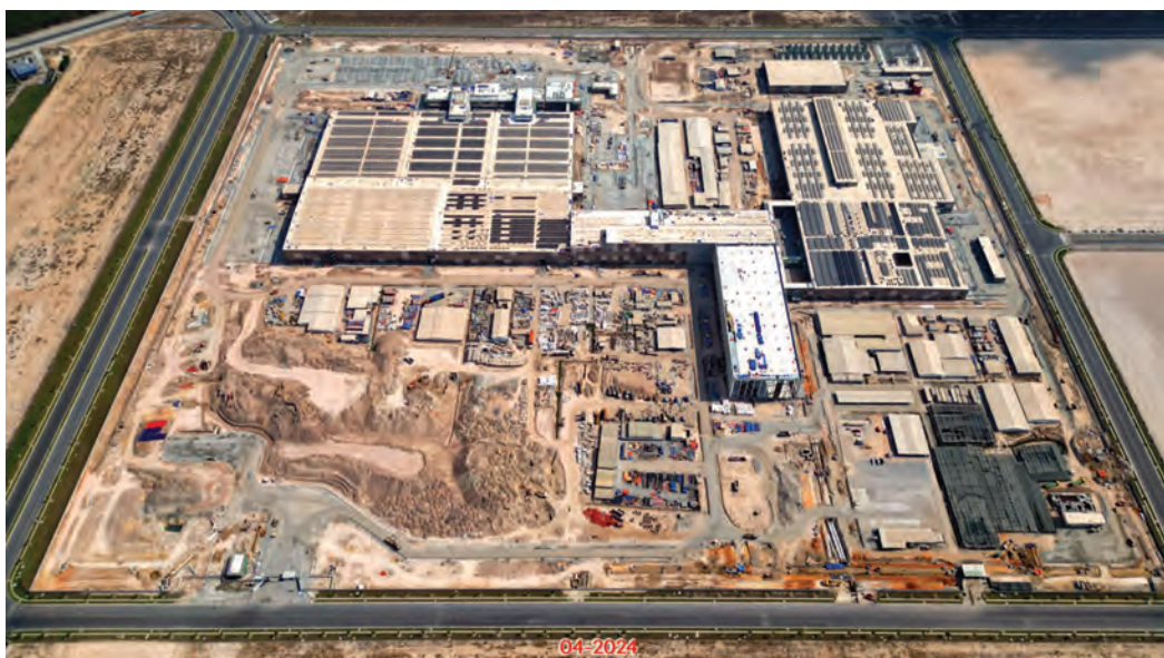
Toàn cảnh hình ảnh công trường thi công.
