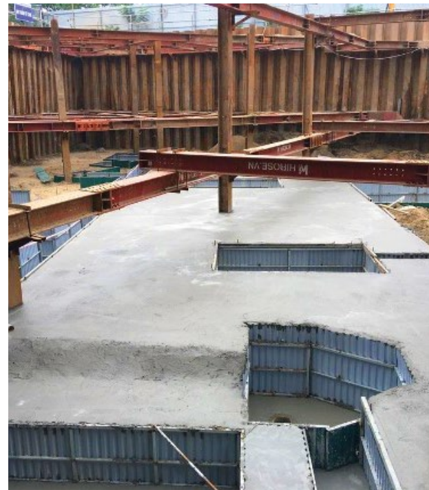
Áp dụng cốp pha tole đổ móng sàn toàn khối
