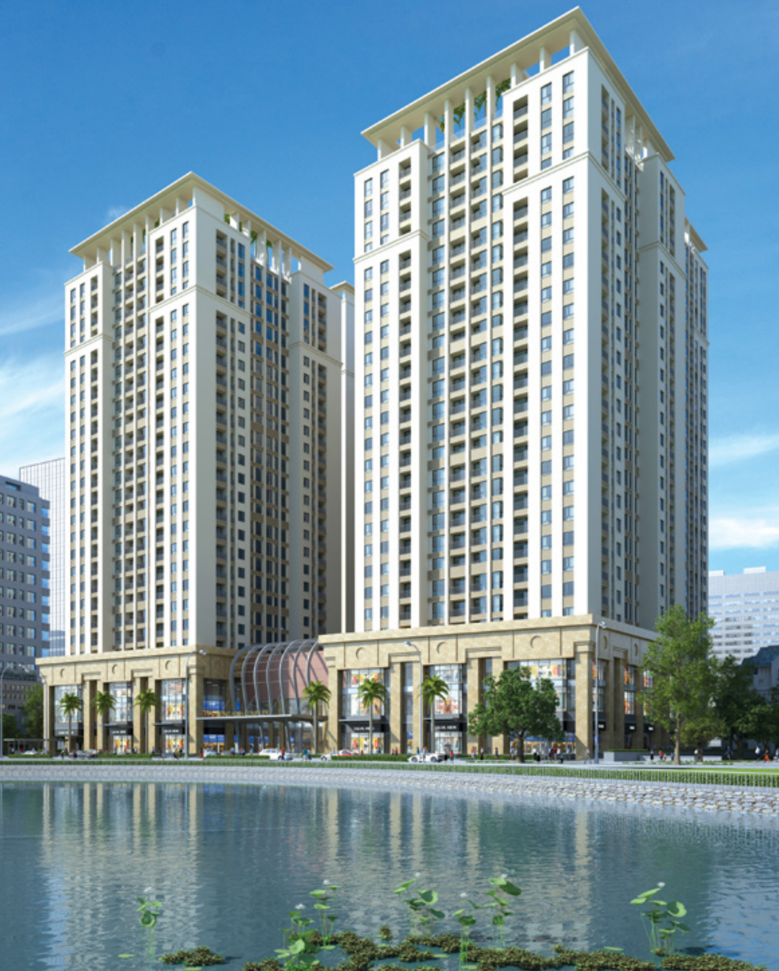
Khu chung cư Trung Kính Complex - Hà Nội
