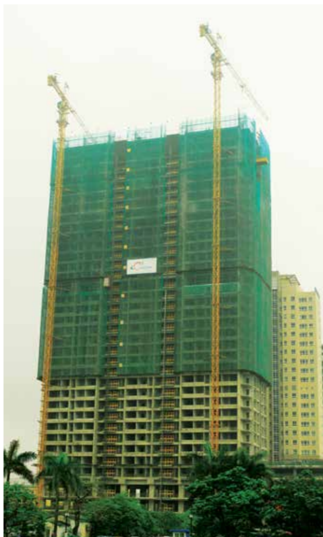
Công trường Coteccons đang thi công
