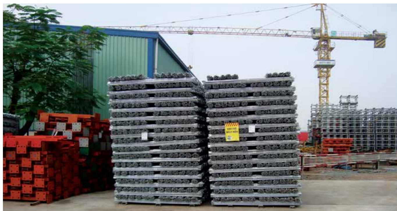
Vật tư thiết bị tại kho được sắp xếp gọn gàng
