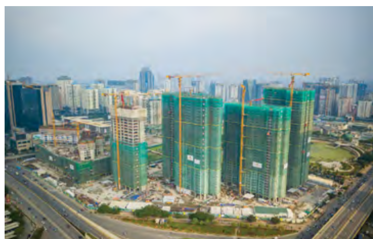
Chinh phục hệ dầm chuyển lớn nhất tại công trường D'Capital
