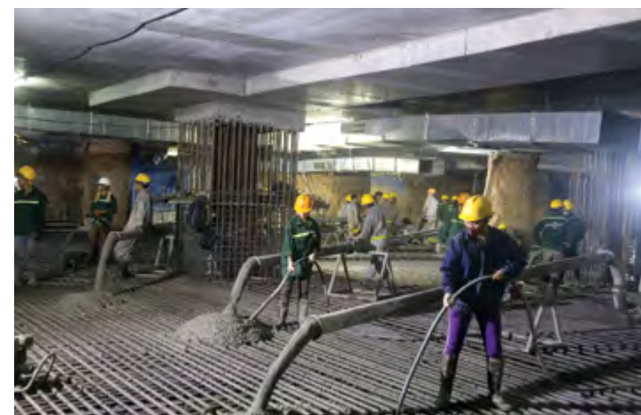
32.305 m 3 bê tông - 45,5 giờ và khối bê tông lớn nhất tại Coteccons
