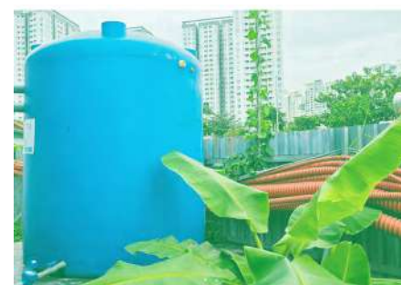
Bể thu gom nước mưa tận dụng cho vệ sinh và tưới cây
